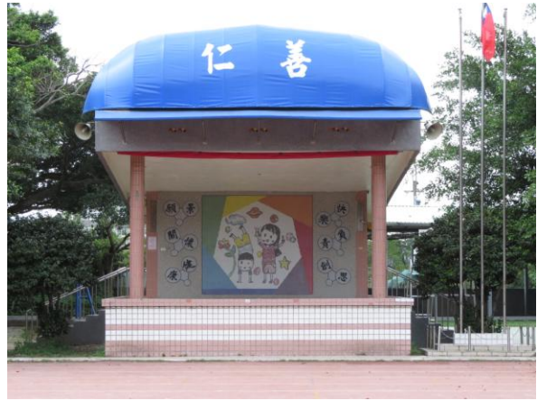
司令台施工後
