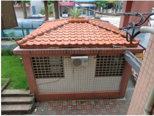
警衛室施工前
