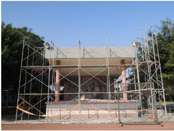
司令台施工前
